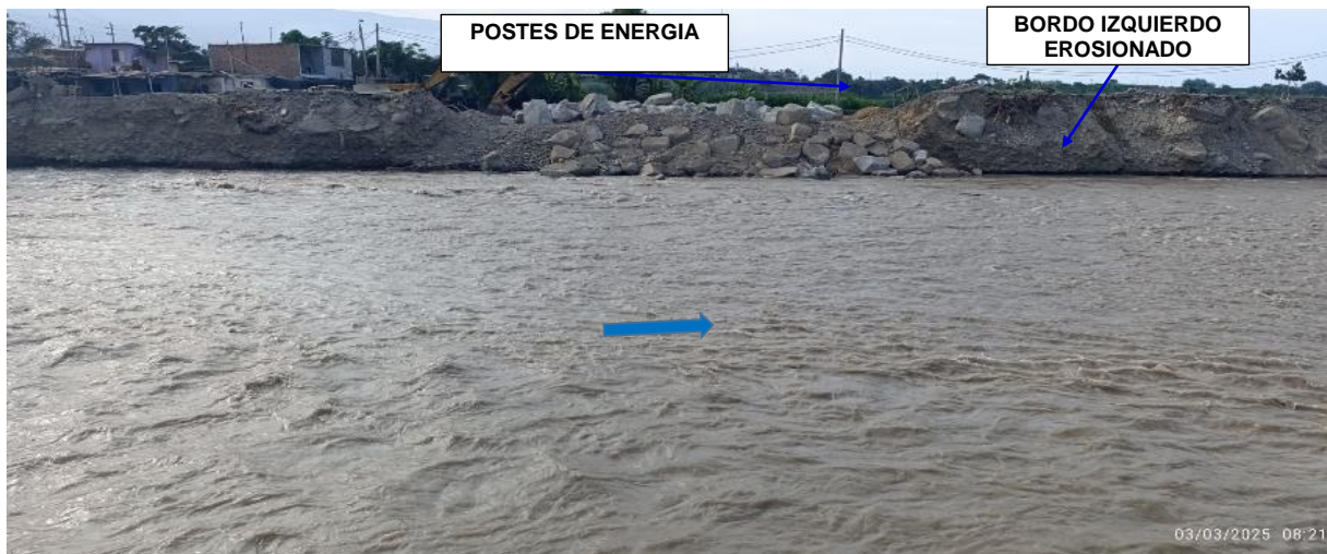
FIGURA N°02: RÍO CHANCAY HUARAL, DONDE LA MARGEN IZQUIERDA CORRESPONDE A LA ZONA DE MANGLAR AFECTADO POR LA DEGRADACIÓN AVANZADA DE SU DIQUE DE PROTECCIÓN GENERANDO INESTABILIDAD GEOMORFOLÓGICA Y RIESGO DE INUNDACIÓN EN
