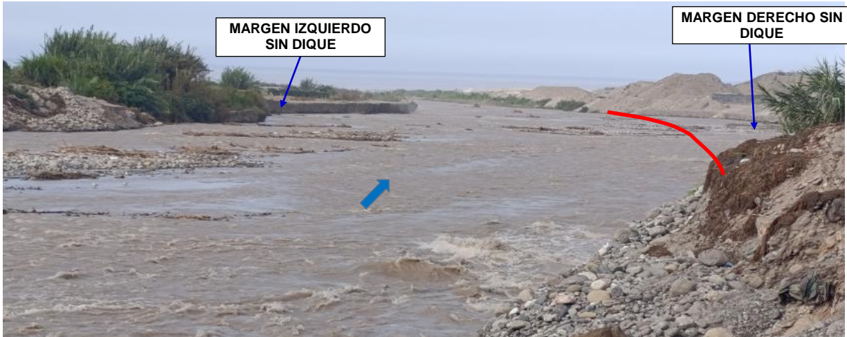
FIGURA N°04: RIO CHANCAY HUARAL, CON LOS DIQUES CONFORMADO DE MATERIAL PROPIO CON DEGRADACIÓN AVANZADA EN AMBAS MARGENES Y EL CAUCE DEL RIO COLMATADO DE FLUJO DE DETRITOS, GENERANDO INESTABILIDAD GEOMORFOLÓGICA Y RIESGO DE INUNDACIÓN EN EL SECTOR.
