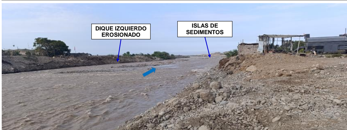
FIGURA N°03: RÍO CHANCAY HUARAL, MARGEN IZQUIERDA Y DERECHA SECTOR SALINAS BAJO AFECTADO POR LA DEGRADACIÓN AVANZADA DE SUS DIQUES DE PROTECCIÓN CONFORMADO POR EL MATERIAL PROPIO .
