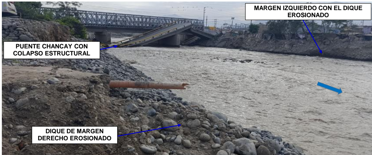
FIGURA N°01: RÍO CHANCAY-HUARAL PRESENTA CAUCE CON COLMATACIÓN, DONDE LA MARGEN IZQUIERDA CORRESPONDE A MANGLAR AFECTADO POR LA DEGRADACIÓN AVANZADA DE SU DIQUE DE PROTECCIÓN, GENERANDO INESTABILIDAD.
